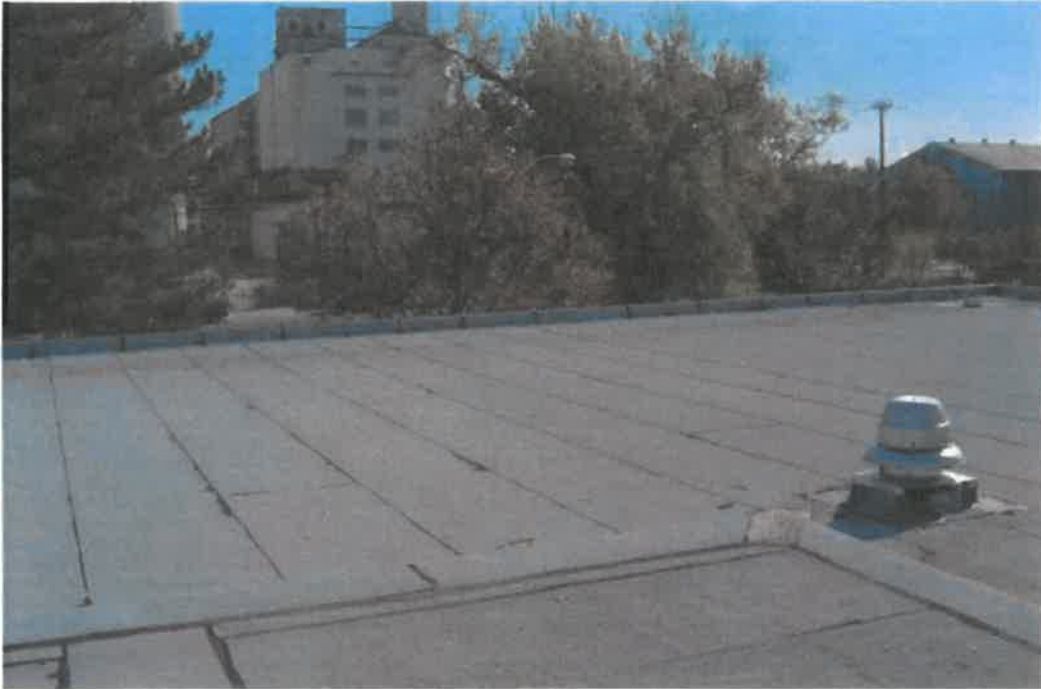
4.1.1.2.1. - EF#1 Exhaust Fan - View 1870
